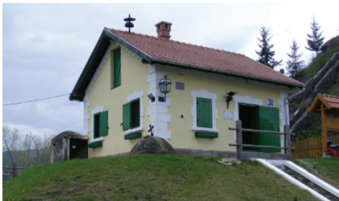
A felújított 30-as számú vasúti őrház az Ezeréves határon
