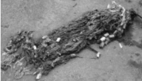
Két hét alatt felgyülemlett hulladék az egyik átemelő szivattyú vezérlőkábelén
